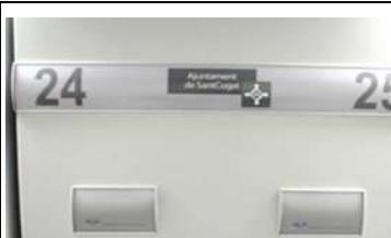
**Carenados frontales y traseros:** están realizados en chapa metálica pintada al epoxy, en una sola pieza, cubriendo todo el frontal del armario. Pueden llevar perforaciones para mejorar la renovación de aire en el interior de los armarios.
